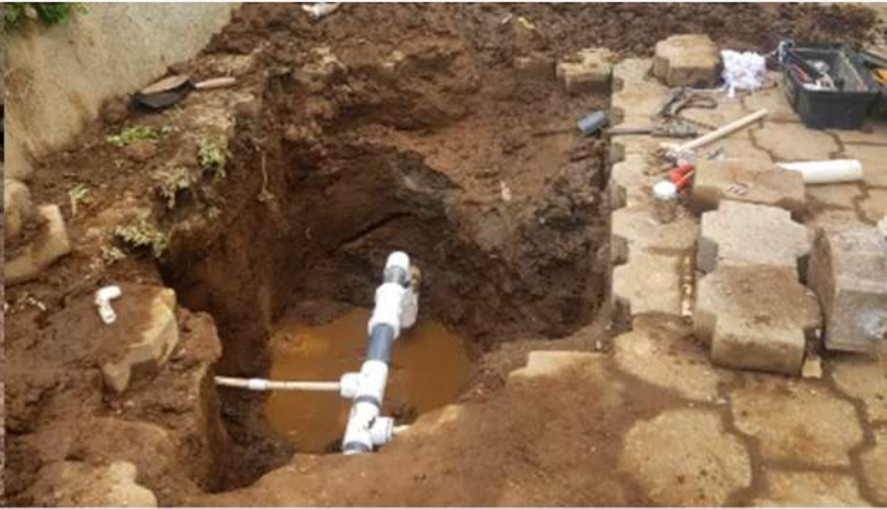
REPARACION DE FUGAS EN LA RED DE AGUA POTABLE EN DISTINTOS PUNTOS DEL MUNICIPIO
