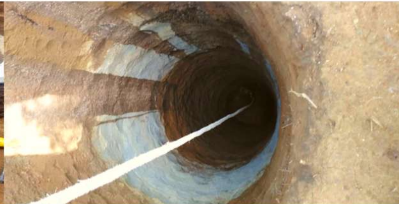
Sistema de Aguas Pluviales
