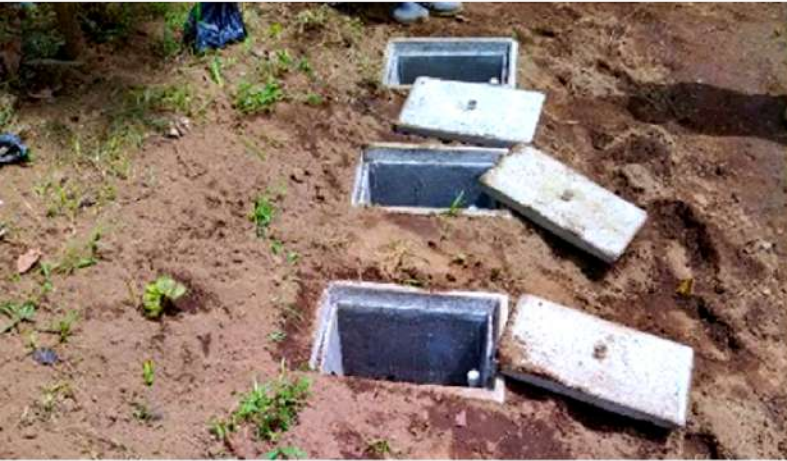
INSTALACION DE SERVICIOS DE AGUA POTABLE CON SUS RESPECTIVO MEDIDOR Y CAJA DE CONCRETO
