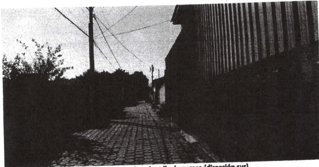
Fotografía No. 4 Vista de calle de acceso (dirección sur)
